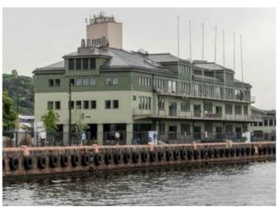
Dritter Platz: Bei der ehemaligen Hafenmeisterei in Oslo waren die mit dem Dämmputz HASIT Fixit 222 gedämmten Außenwände nach drei Jahren frei von Feuchtigkeitsüberschüssen und boten einen hervorragenden Witterungsschutz.
