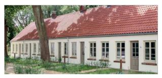
Zweiter Platz: Bei den 1904 gebauten Reihenhäusern "Langer Jammer" konnten dank der Außendämmung mit dem Dämmputz HASIT Fixit 222 die steinsichtigen Fenstersohlen und die Kubatur erhalten werden.
