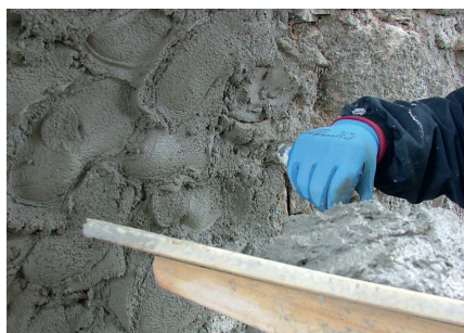
Bouchon avec enduit barrière Fixit 217 Délai d'attente env. 5 jours
