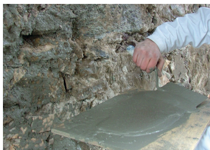
Prégiclage avec Fixit 211 Prégiclage au ciment avec adjuvant d'adhérence. Délai d'attente env. 4 – 5 jours
