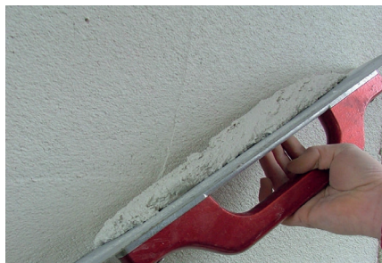
Enduit de rénovation Fixit 462 d'environ 10 mm d'épaisseur comme couche d'enduit anti-humidité Instruire. (Risque de condensation)
