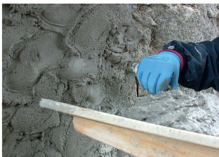
Egaliser avec Fixit 217 Enduit d'étanchéité. Délai d'attente env. 3 semaines
