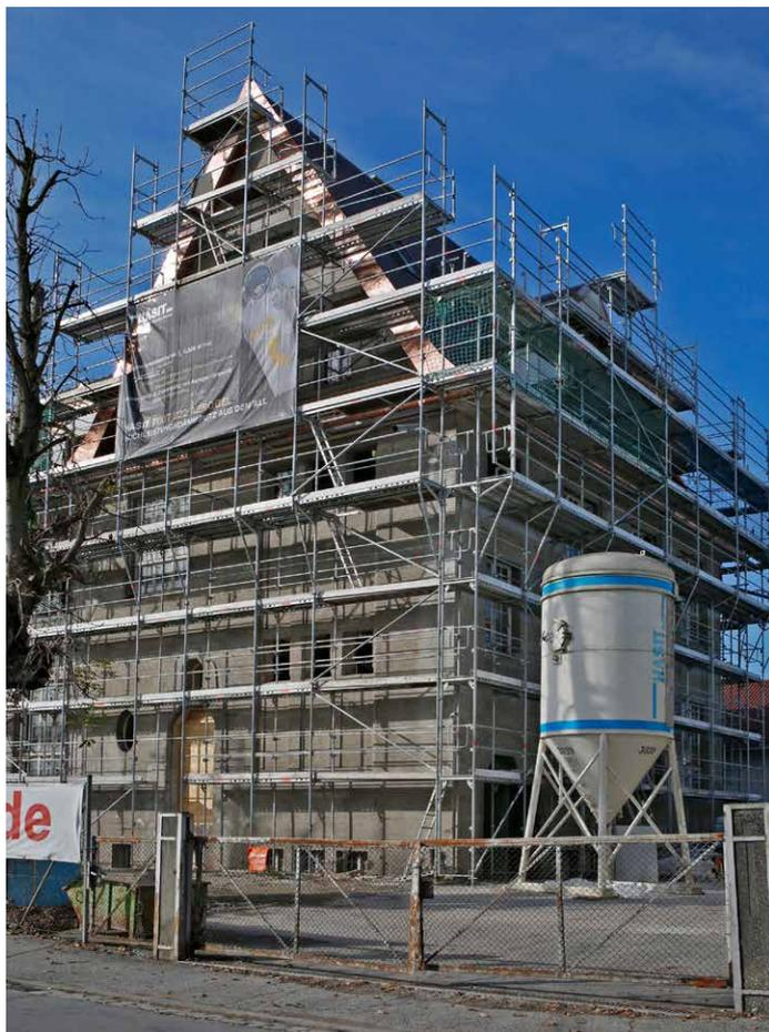
dessen „bewehrten Aufbau“ schadensfrei abgefangen. Mit den restlichen Schichten blieb man im vorgegebenen Systemaufbau. Nach dem Auftragen eines Silikatverfestigers (HASIT PP 201) wurde der mineralische Einbettmörtel „Fixit 223“ aufgebracht. Er ist ähnlich dem darunterliegenden Hochleistungsdämmputz auf-
