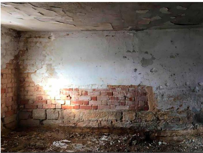
Teilweise keine Bodenplatten vorhanden (Lehmboden)
