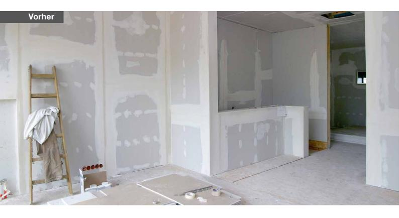
Ein Großteil der heutigen Neubau- und Sanierprojekte werden im Innenbereich mit Gipsbauplatten umgesetzt. Im Neubau oftmals als Ständerwerk aus Metall oder Aluminium erstellt, werden diese Platten als Verkleidung genutzt. Bei der Altbausanierung werden die Platten auf verschiedene vorhandene Untergründe geklebt. Das Ergebnis ist jeweils eine glatte, gefugte Kartonoberfläche, die im Anschluss noch verspachtelt und strukturiert werden muss.
