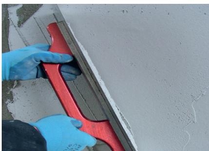
Etanchéité avec Fixit 373 Multiflex 2 K gris.
