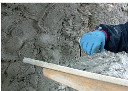
Egaliser avec Fixit 217 Enduit d'étanchéité.
