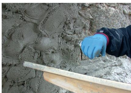
Bouchon avec enduit barrière Fixit 217
