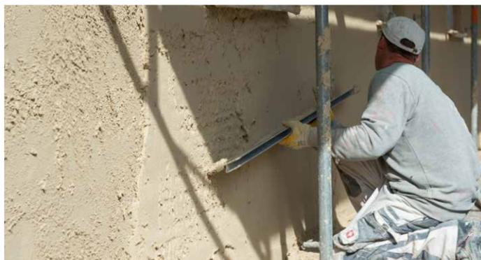
Nach Abnehmen des alten Putzes und Auskratzen von losen Fugenmörtel führten die Verarbeiter einen dreischichtigen Aufbau aus: Spritzbewurf, Grundputz, Oberputz.
