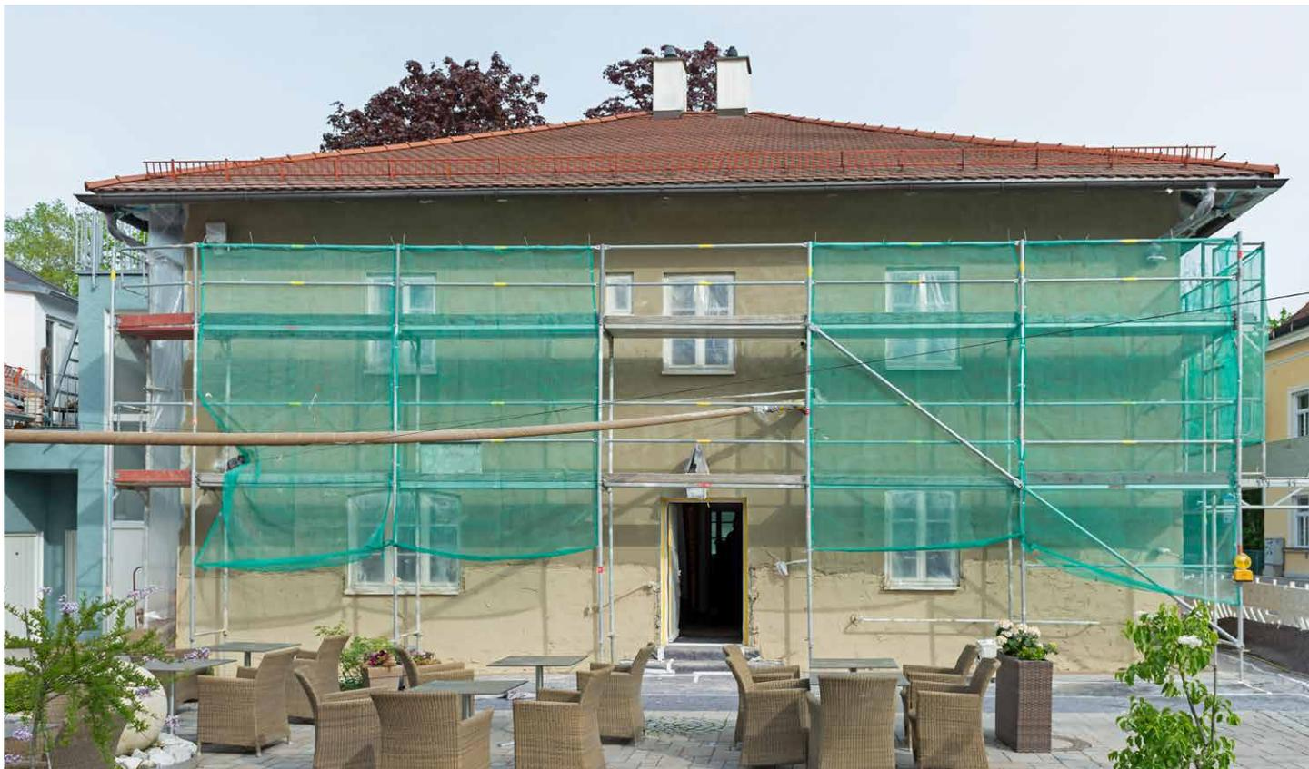
Oberhalb des Sockels kamen schnell abbindende Kalkzementputze zum Einsatz, was den Baufortschritt beschleunigte.
