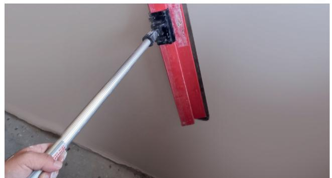
Er wird mit der Rolle oder mit der Trichterpistole auf den Fixit 166 SL plus Gips-Maschinenputz aufgetragen und sorgt für eine glatte Oberfläche durch den Verschluss der Poren.
