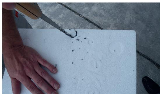
Sciez les bouchons adaptés au trou de l'échafaudage à l'aide d'une scie sauteuse et vérifiez que la taille est correcte. En général, le bouchon devrait être plus grand que le trou original.
