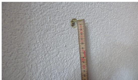
Retirez les particules de mortier détachées du trou de l'échafaudage et mesurez la taille du trou.
