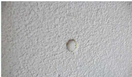
Mélangez le crépi de finition et laissez durcir quelques minutes. Lors du remplissage du trou de l'échafaudage, le crépi doit avoir une certaine rigidité pour faciliter le modelage ultérieur.
