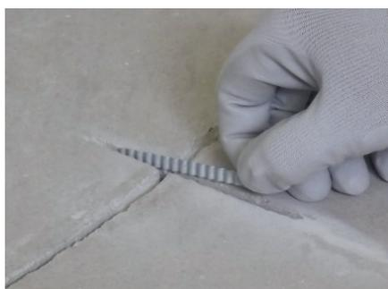
Sobald alle aufgeschnittenen Risse und Spalten staub- und fettfrei sind, können die Wellenverbinder in sämtliche Querschnitte gelegt werden. Es ist darauf zu achten, dass die Wellenverbinder vollständig im Einschnitt verschwinden. Haben die Wellenverbinder nicht komplett im Schnitt platz, ist der Schlitz nicht tief genug und er muss nochmals nachgeschnitten und gereinigt werden.
