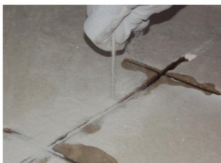
Sobald der Schnitt gefüllt ist, muss das Harz mit Quarzsand (Körnung ca. 0,2 bis 0,7 mm) während der Offenzeit abgestreut werden.
