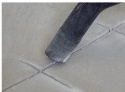
Nachdem das Einschneiden abgeschlossen ist, wird mit einem Staubsauger sämtliches loses Material und Staubteile aus den Schnitten entfernt (staub- und fettfrei).
