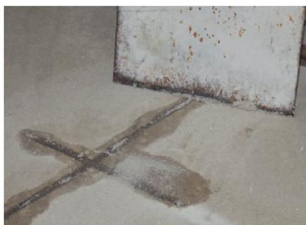
Um eine optimale Oberfläche zur Aufnahme des Oberbelags zu erhalten, werden die Risse anschliessen mit Hilfe einer Kelle oder einem Spachtel geglättet. Nach dem Erhärten den losen Quarzsand durch Abfegen entfernen.
