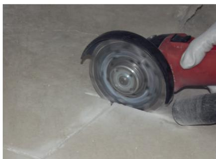
Um den Riss langfristig zu sanieren, wird er z.B. mittels Wellenverbindern vernäht. Damit diese eingesetzt werden können, sollte alle 20 - 30 cm einen ca. 10 cm langen Schnitt, mit einem Winkelschleifer, quer zum Riss eingeschnitten werden.
