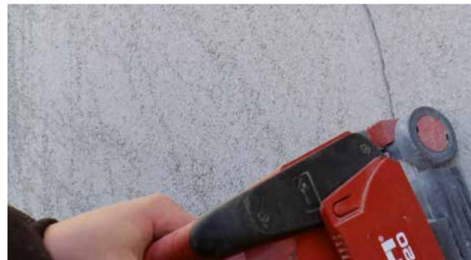
Konstruktionsbedingten Riss oder Kerbriss auffräsen
