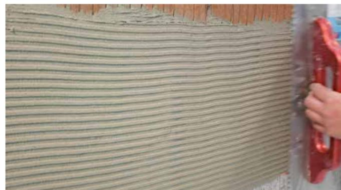
Übergangabsicherung von Betondeckenkränzen zum Ziegelmauerwerk
