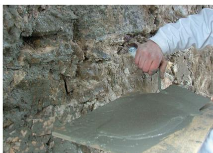
Anwurf mit Fixit 211 Zementmörtel mit Haftzusatz
