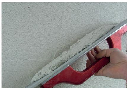
Fixit 462 Renovationsputz ca. 10 mm dick als feuchtegalisierende Putzschicht auftragen. (Tauwassergefahr)
