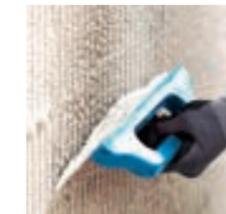
**5 Einbetten des Armierungsgewebes mit Armierungsmörtel**
