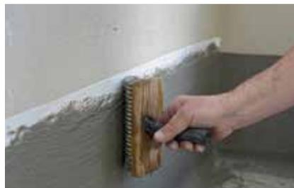
2. Reaktivabdichtung mittels Bürste oder Airless in 2 Schichten auftragen.
