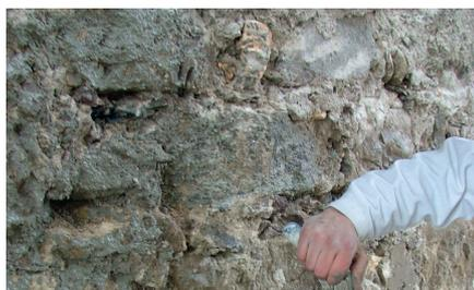
Anwurf mit Fixit 211 Zementmörtel mit Haftzusatz, maximal 50 % deckend.
