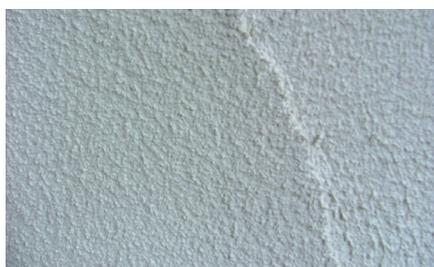
Bei geringer Versalzung kann der Sanierputz fertig bearbeitet werden.
