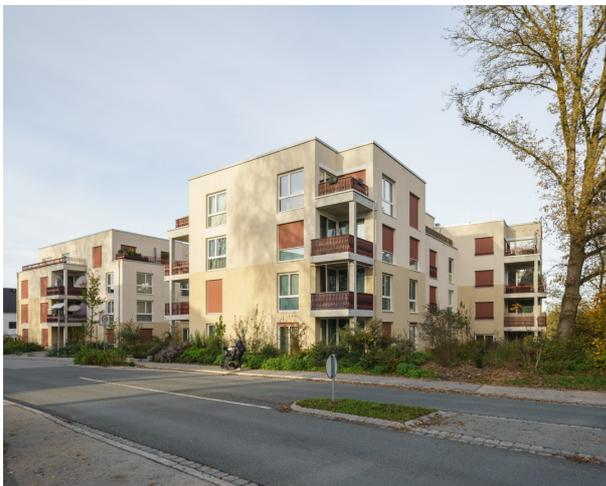
Die verputzte Fassade der viergeschossigen Wohnbauten wird über unterschiedliche, fein differenzierte Putzstrukturen gegliedert.
