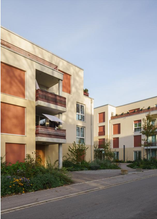
Die Ausführung der Putzoberflächen im Erdgeschoss und 1. Obergeschoss erfolgte teilweise in einer anderen Feinheit als die Geschosse darüber. Dadurch verändert sich der Helligkeitsgrad der Oberflächen im Streiflicht.
